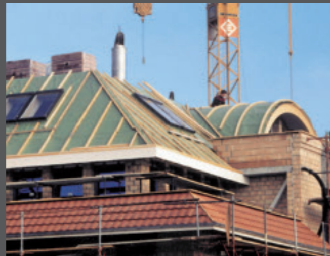
2. Klassisches, mit Ziegeln eingedecktes Steildach – mit Wärmedämmung über Sparren und fugenlosem Unterdach.
