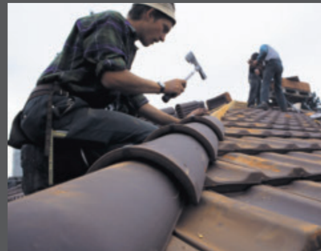
3. Gratziegel werden Stück um Stück angepasst und mit grösster Präzision montiert.
