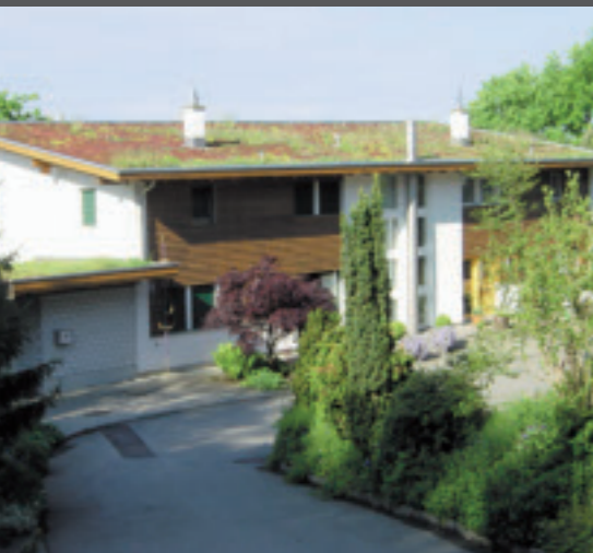
1. Auch mit einem Steildach lassen sich ökologische Vorteile einer Begrünung nutzen.
