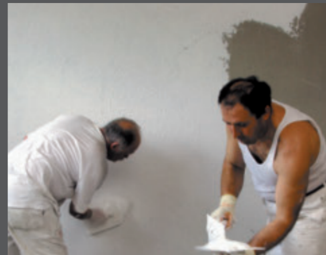
3. Mit Reibscheibe, Spachtel, Kelle, Bürste oder Schwamm wird dem Oberputz die gewünschte Struktur gegeben.
