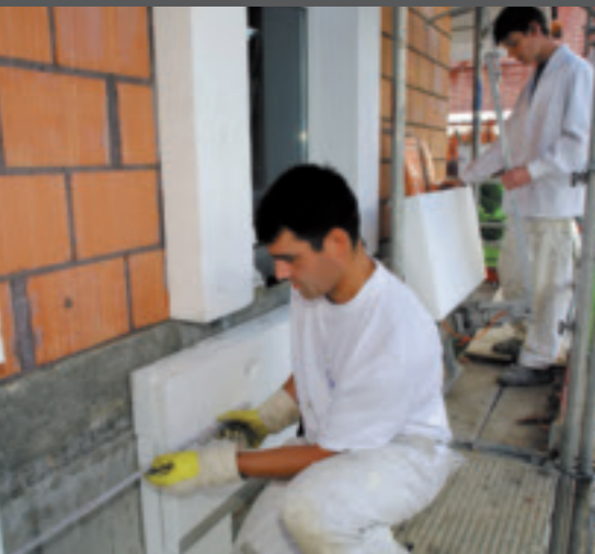
1. Fassadenisolation aus expandiertem Polystyrol (Styropor) verbessert das Wohnklima und schont das Portemonnaie.
