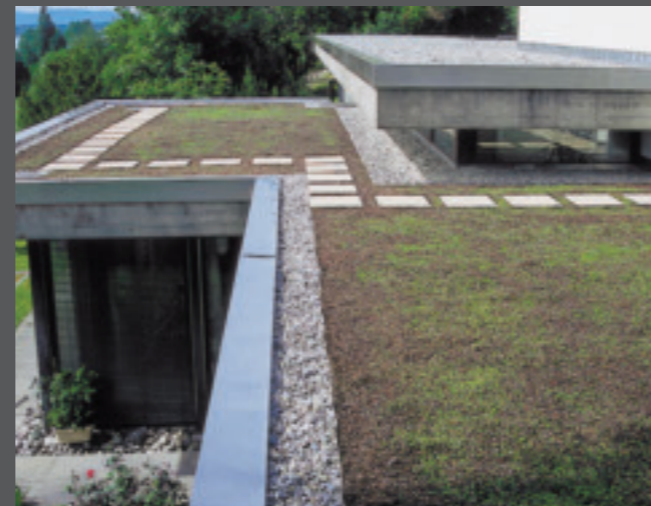
3. Eine beispielhafte Flachdachsanierung: Kompaktdach mit extensiver Begrünung und neuen An- und Abschlüssen aus Blech.
