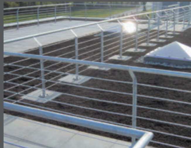
2. Das Flachdach über der Wohnung wurde mit Gehwegplatten teilweise begehbar gemacht. Ein Teil ist extensiv begrünt. Und das Ganze ist mit ästhetischem Schutzgeländer eingefasst.
