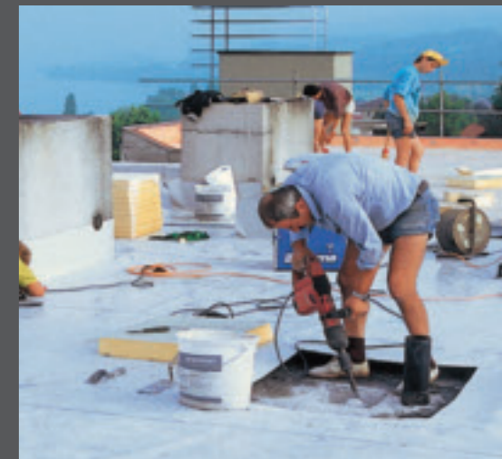
5. Mit neuer Wärmedämmung und Folienabdichtung erhöhen sanierte Flachdächer nicht nur den Wohnkomfort, sondern auch die Energieeffizienz beträchtlich.
