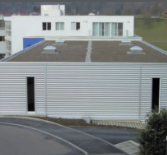
1. Gewerbegebäude mit bituminöser Abdichtung und extensiver Dachbegrünung. Die kleine Terrasse vor dem Bürotrakt bietet willkommenen Erholungsraum.
